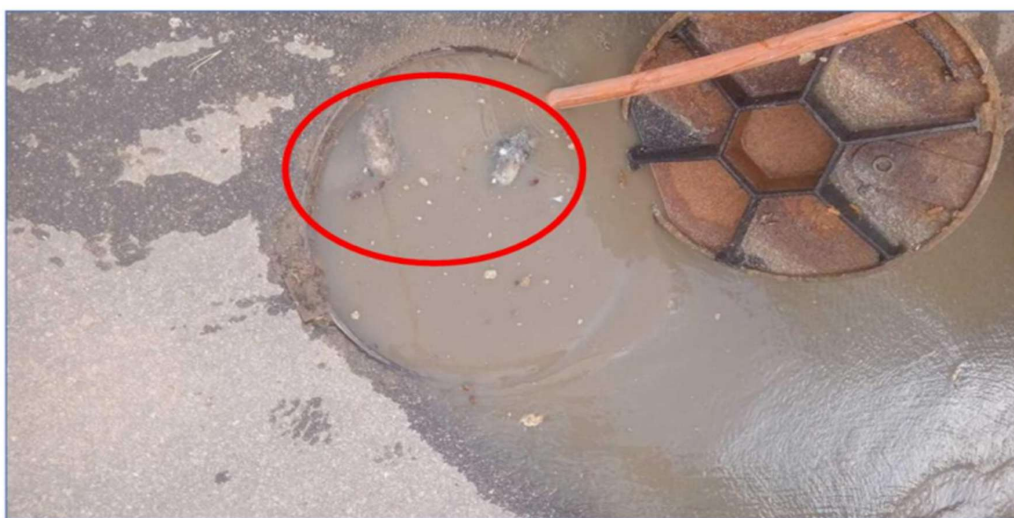
Imagem 1: OS nº2521149713 equipe iniciando o serviço de limpeza e desobstrução de rede. É possível observar objetos sólidos estranhos que foram removidos durante a limpeza (circulados em vermelho), e acúmulo de gordura.
