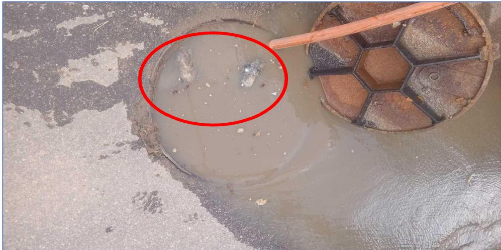
Imagem 1: OS n°2521149713 equipe iniciando o serviço de limpeza e desobstrução de rede. É possível observar objetos sólidos estranhos que foram removidos durante a limpeza (circulados em vermelho), e acúmulo de gordura.
