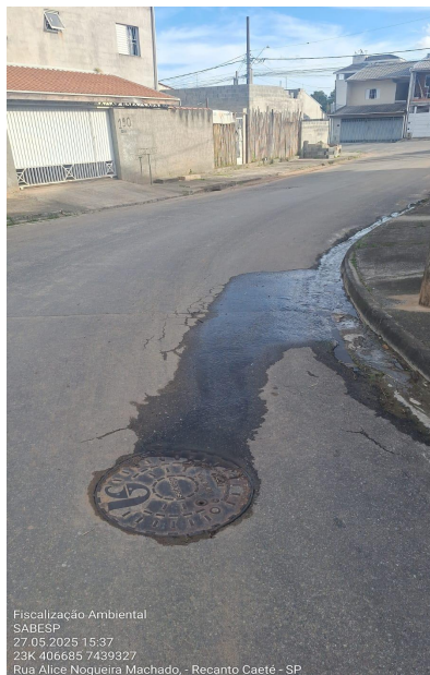
Figura 2: Esgoto sanitário extravasando em via pública. Fonte: Arquivo CPAVP 27/05/2025.
