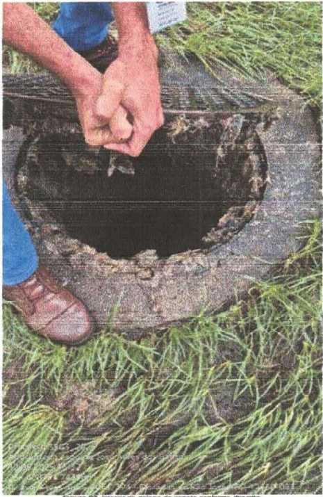
Figura 02. Interior da caixa de esgoto coletor, descrito.
