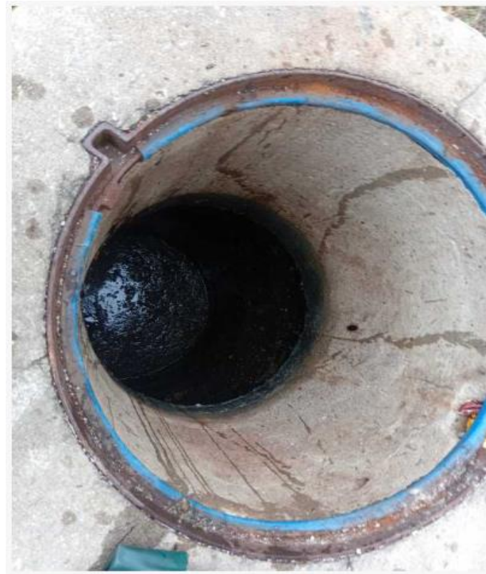
Figura 7 – Poço em funcionamento normal após a desobstrução
