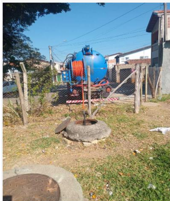
Figura 1 – Início da desobstrução e remoção de resíduos sólidos no dia 16/07/2025
