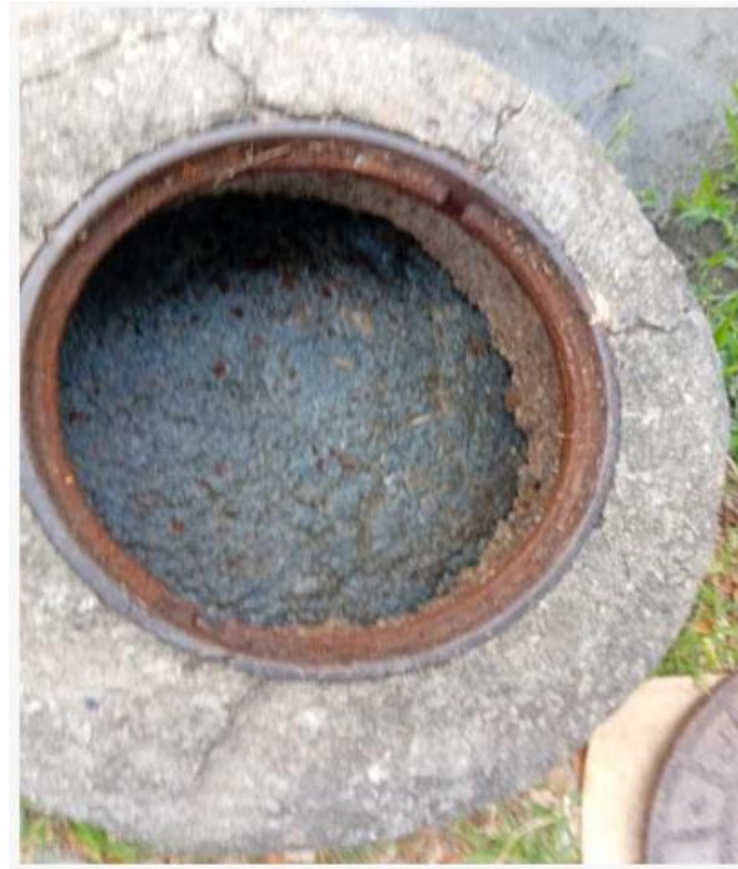
Figura 6 – Poço antes da desobstrução e remoção de resíduos presentes na rede coletora de esgoto.
