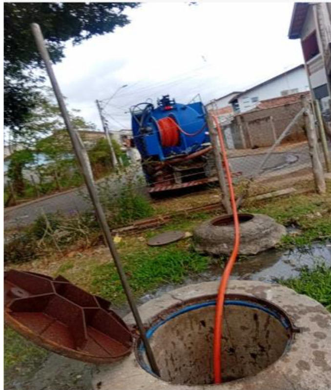
Figura 5 – Início da desobstrução e remoção de resíduos sólidos no dia 16/09/2025
