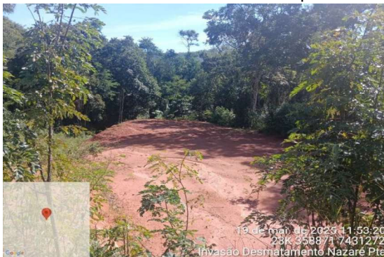
Área 3 Foto 33 – Terraplanagem e movimentação de terra na área da Sabesp.
