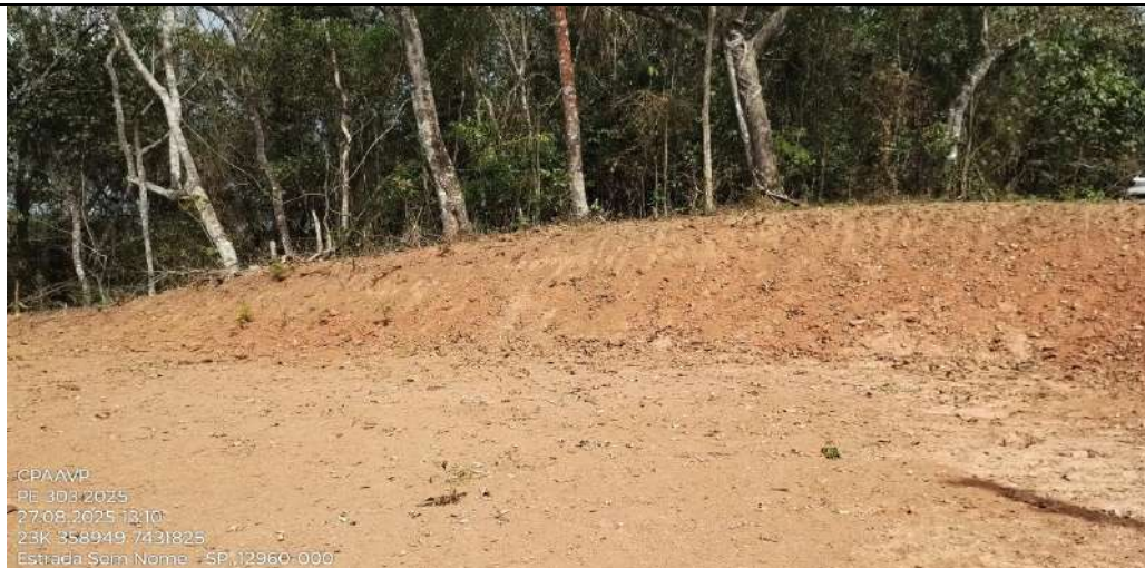
Figura 12. Área com movimentação de terra às margens da estrada. FONTE: CPAAVP, 2025
