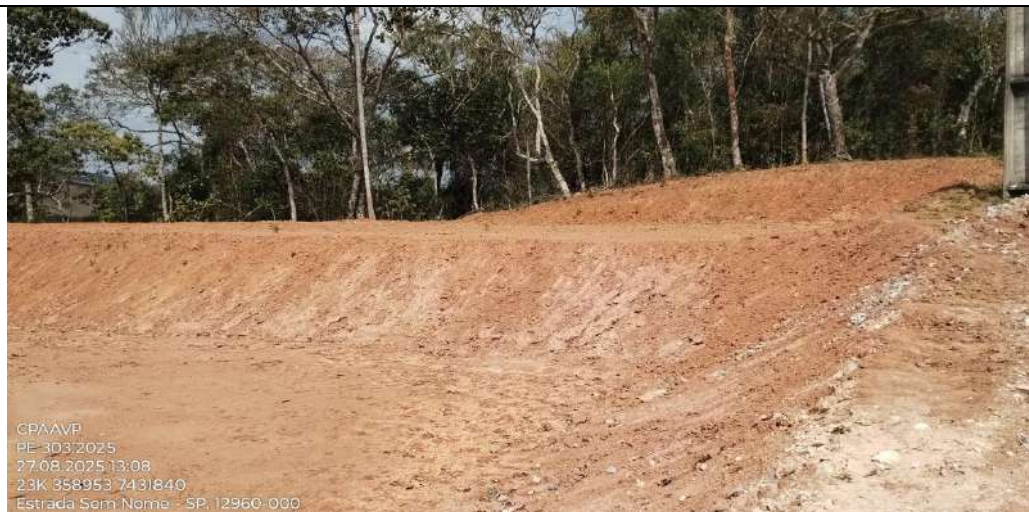
Figura 10. Área com movimentação de terra às margens da estrada. FONTE: CPAAVP, 2025
