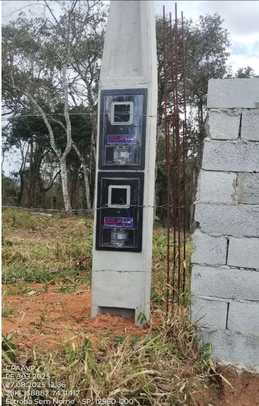
Figura 17. Poste padrão de energia. FONTE: CRAAVP, 2025
