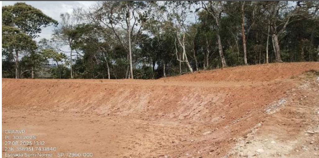
Figura 13. Área com movimentação de terra às margens da estrada. FONTE: CPAAVP, 2025
