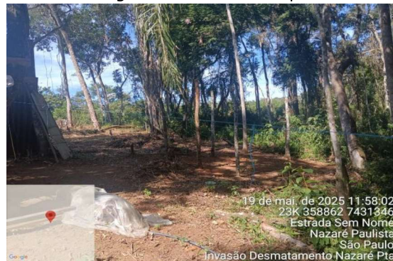
Área 3 Foto 30 – Supressão vegetal na área da Sabesp.
