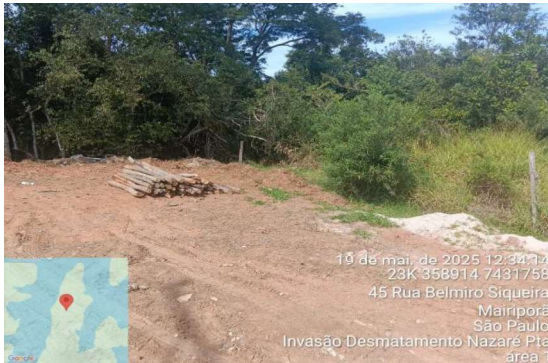
Área 1 Foto 09 – Terraplanagem e mourões para demarcação de lotes dentro da área da Sabesp.
