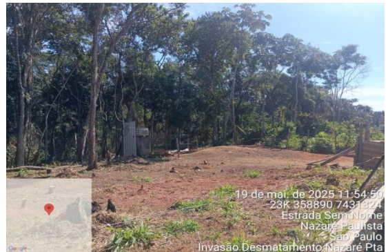
Área 3 Foto 28 – Terraplanagem e supressão vegetal na área da Sabesp.
