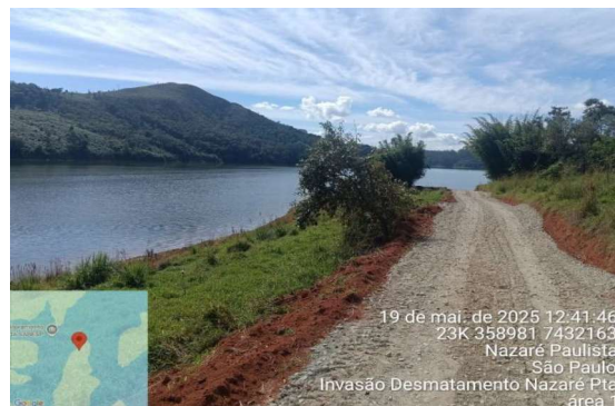
Área 1 Foto 06 – Movimentação de terra dentro da área da Sabesp.
