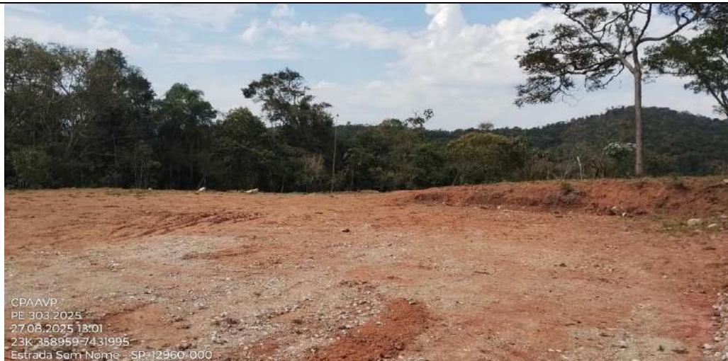
Figura 6. Área com movimentação de terra às margens da estrada. FONTE: CPAAVP, 2025
