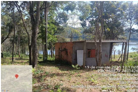
Área 3 Foto 27 – Abrigo de alvenaria na área da Sabesp.
