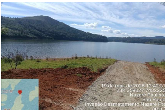
Área 1 Foto 05 – Movimentação de terra na área de APP.
