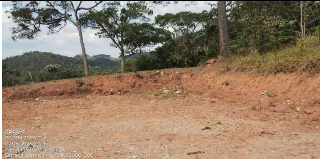
Figura 9. Área com movimentação de terra às margens da estrada. FONTE: CPAAVP, 2025
