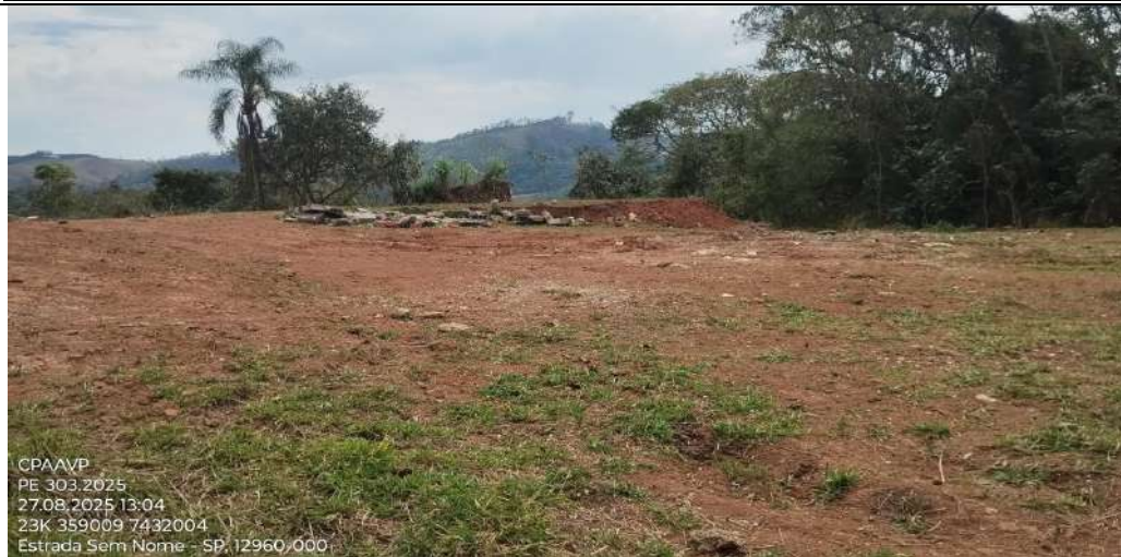
Figura 7. Área com movimentação de terra às margens da estrada. FONTE: CPAAVP, 2025
