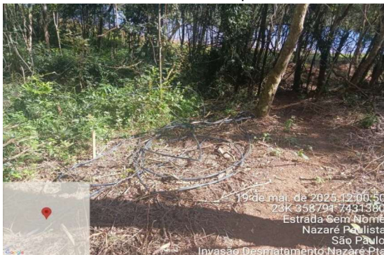
Área 3 Foto 39 – Captação de água na área da Sabesp.
