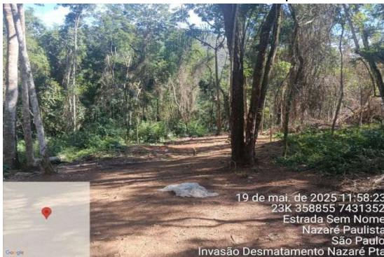
Área 3 Foto 35 – Supressão vegetal na área da Sabesp.
