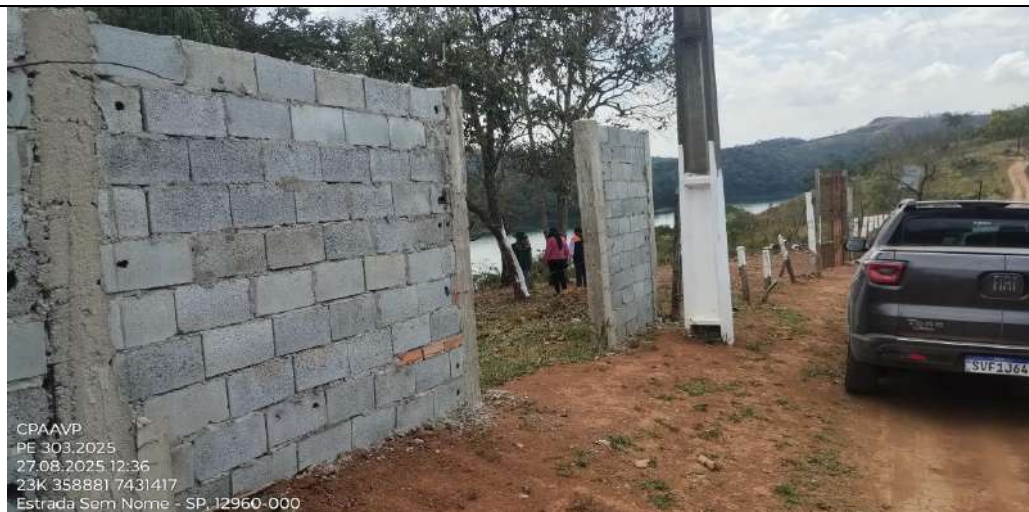
Figura 16. Muro e cercamento de área às margens da estrada. FONTE: CPAAVP, 2025
