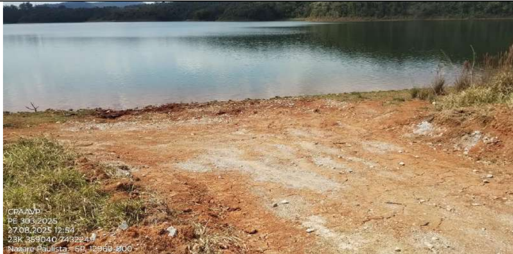
Figura 5. Fim do prolongamento da estrada com intervenção em APP. FONTE: CPAAVP, 2025
