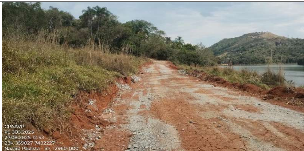
Figura 14. Prolongamento da estrada e resquílios de pedra britada. FONTE: CPAAVP, 2025
