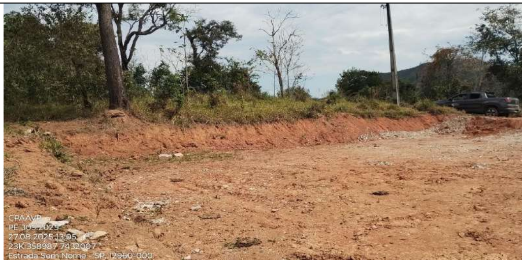
Figura 8. Área com movimentação de terra às margens da estrada. FONTE: CPAAVP, 2025
