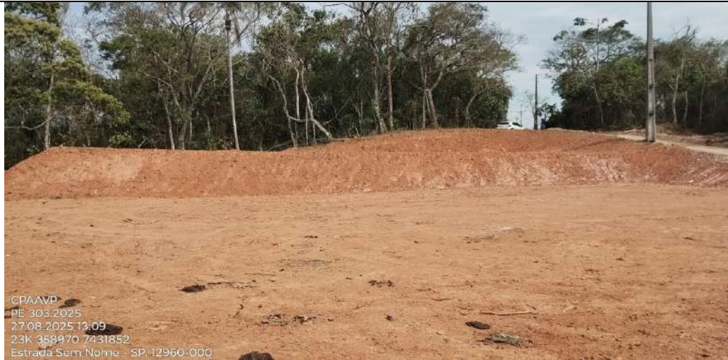
Figura 11. Área com movimentação de terra às margens da estrada. FONTE: CPAAVP, 2025
