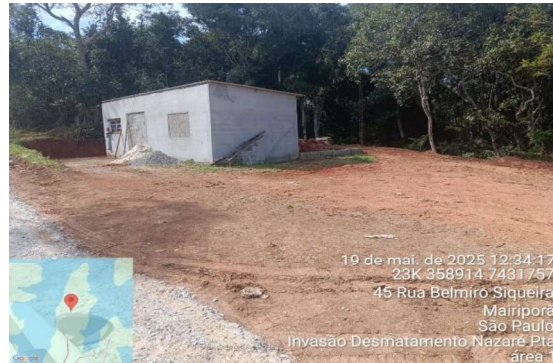
Área 1 Foto 10 – Terraplanagem, supressão e construção em área da Sabesp.
