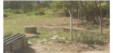
Figura 09. Imagem obtida a partir do Google Street View, datada de 2023, com visada a partir do final da Rua Rio Madeira. As setas vermelhas indicam poços de visita, sendo a mais distante representada pelo ponto 8 na Figura 01.
