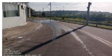
Registro fotográfico 05. Esgoamento do efluente pela via pública.
