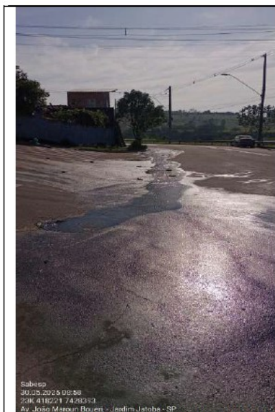
Registro fotográfico 03. Esgoamento do efluente pela via pública.
