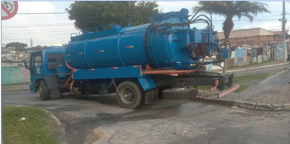
Imagem 3: OS nº2520753904 equipe iniciando o serviço de limpeza e desobstrução de rede
