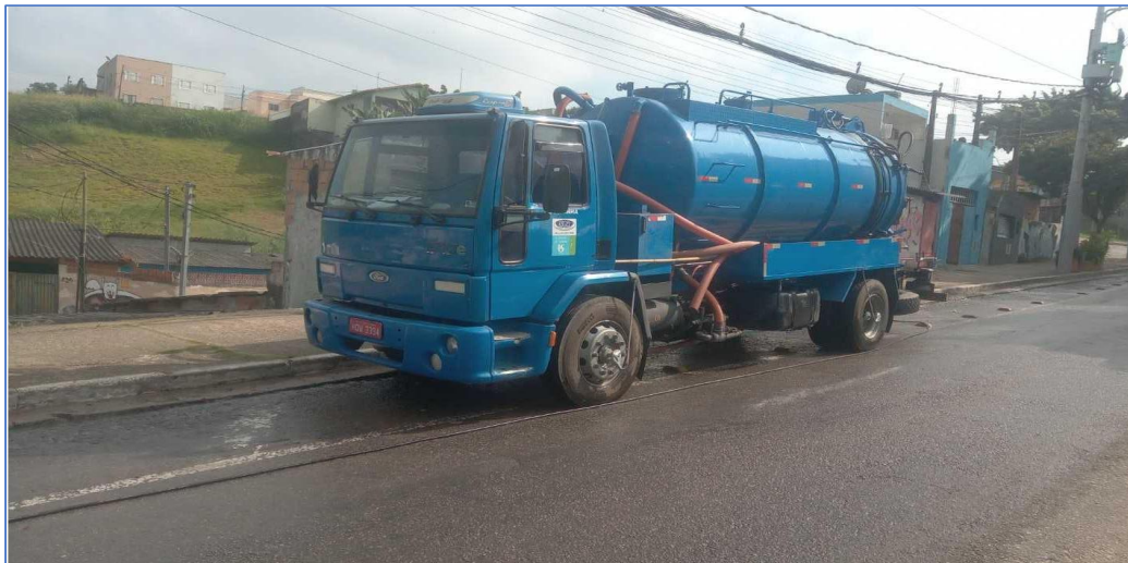
Imagem 5: OS nº2520753904 – Execução do serviço de limpeza e desobstrução de rede
