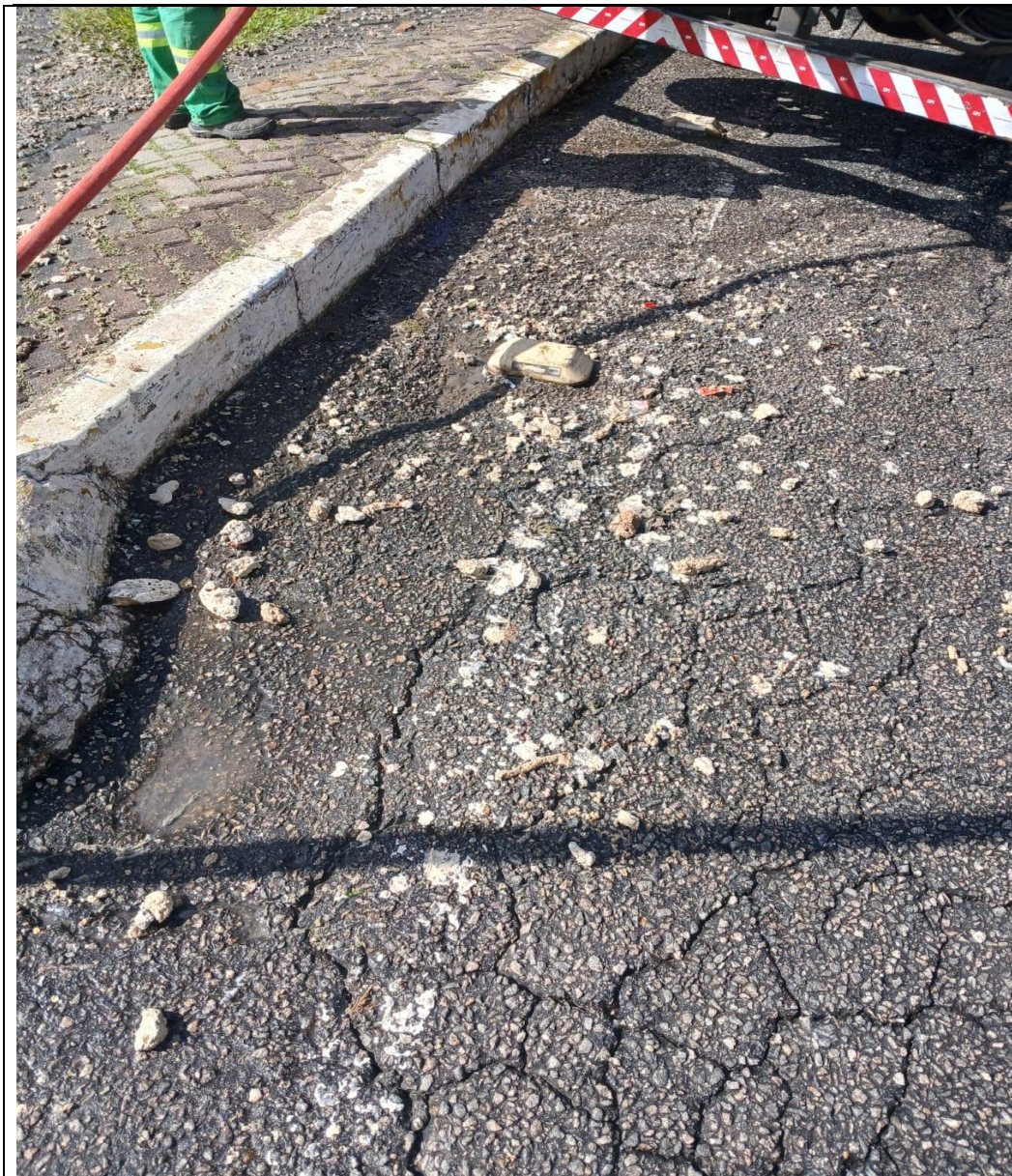
Figura 03. Parte do material gorduroso retirado do sistema de esgoto.
