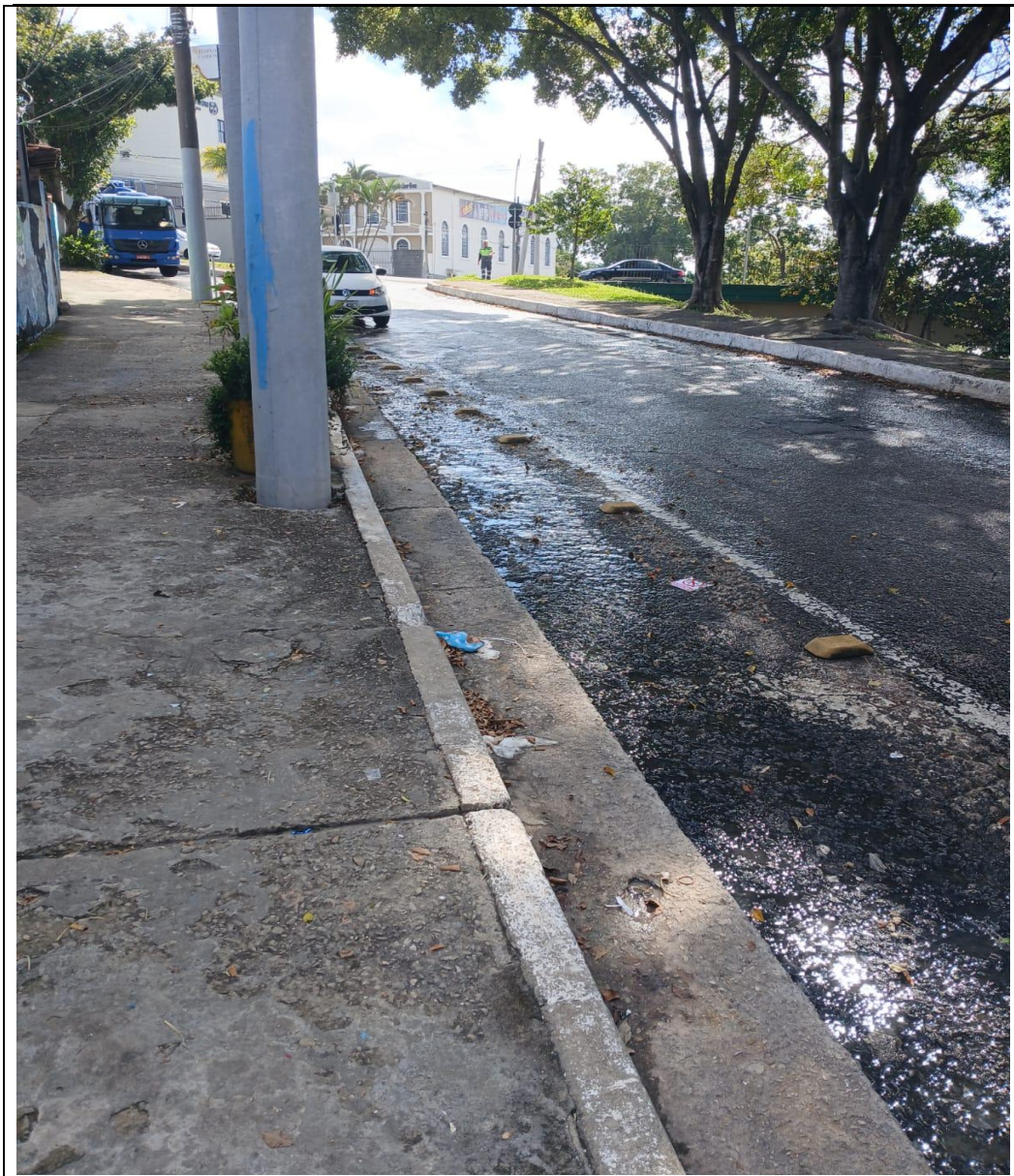
Figura 04. Via com resíduos oleosos e efluentes do esgoto.
