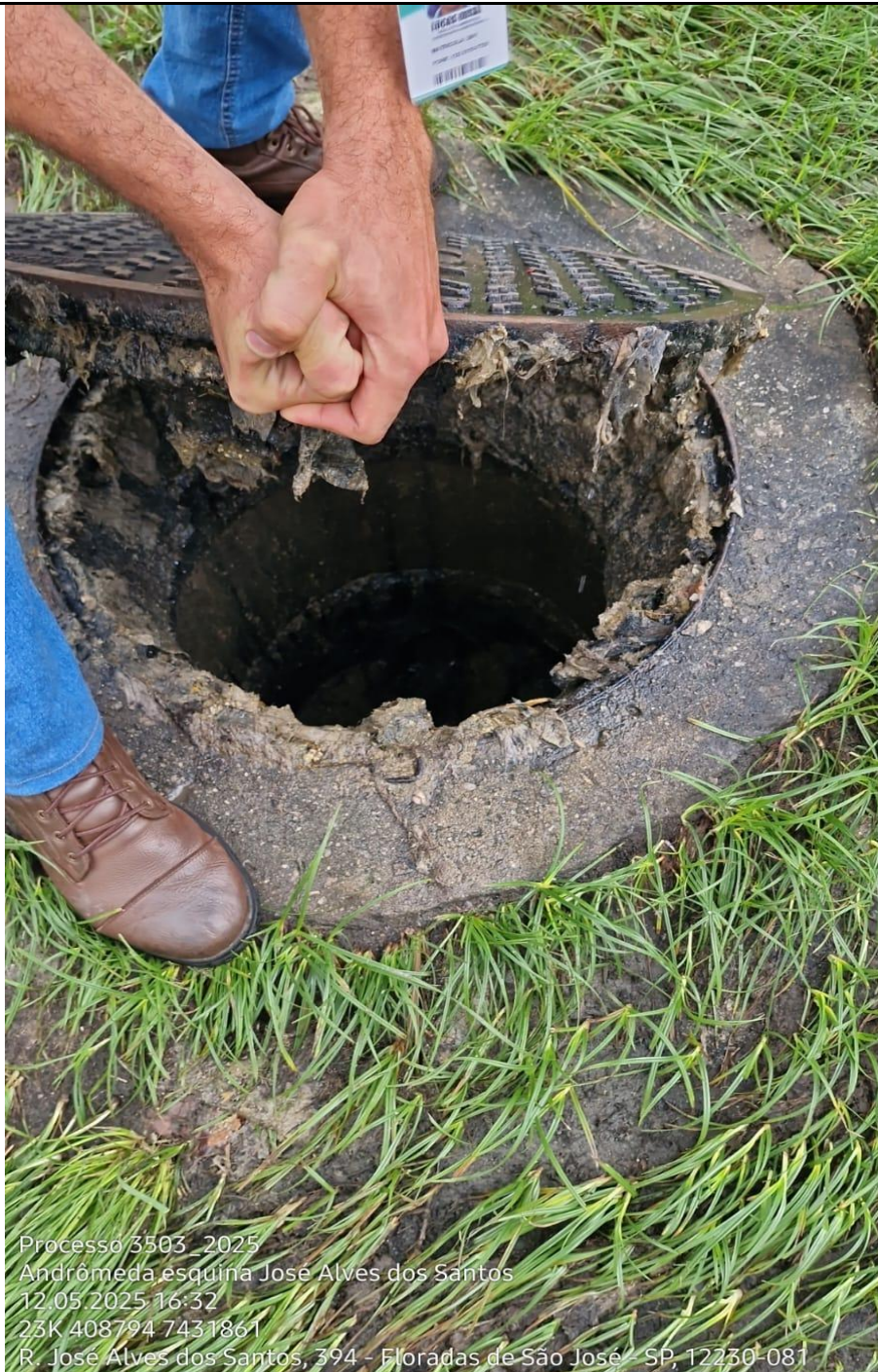
Figura 02. Interior da galeria de esgoto conforme descrito.
