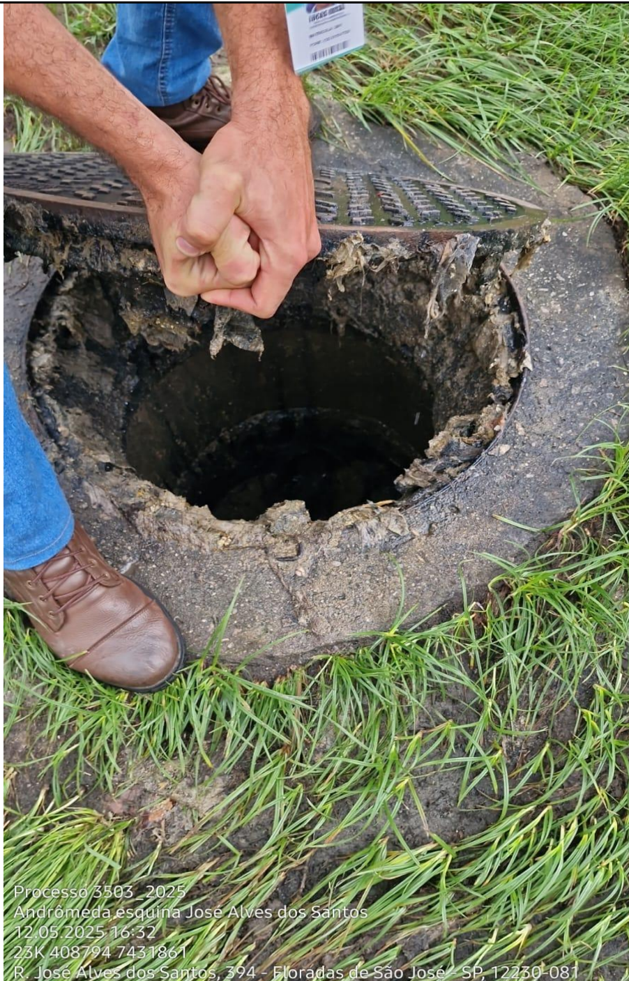
Figura 02. Interior da galeria de esgoto conforme descrito.
